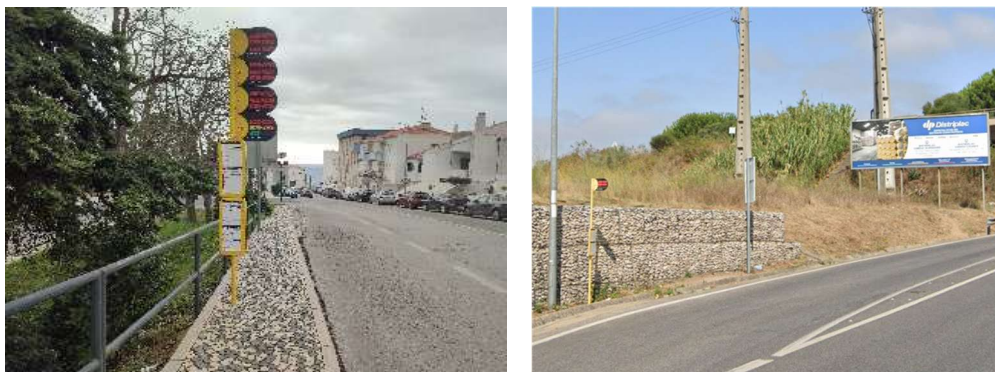
Figura 6.1 – Exemplos de passeios subdimensionados ou inexistência de passeios
